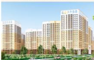
Жилой комплекс «Сталь»
